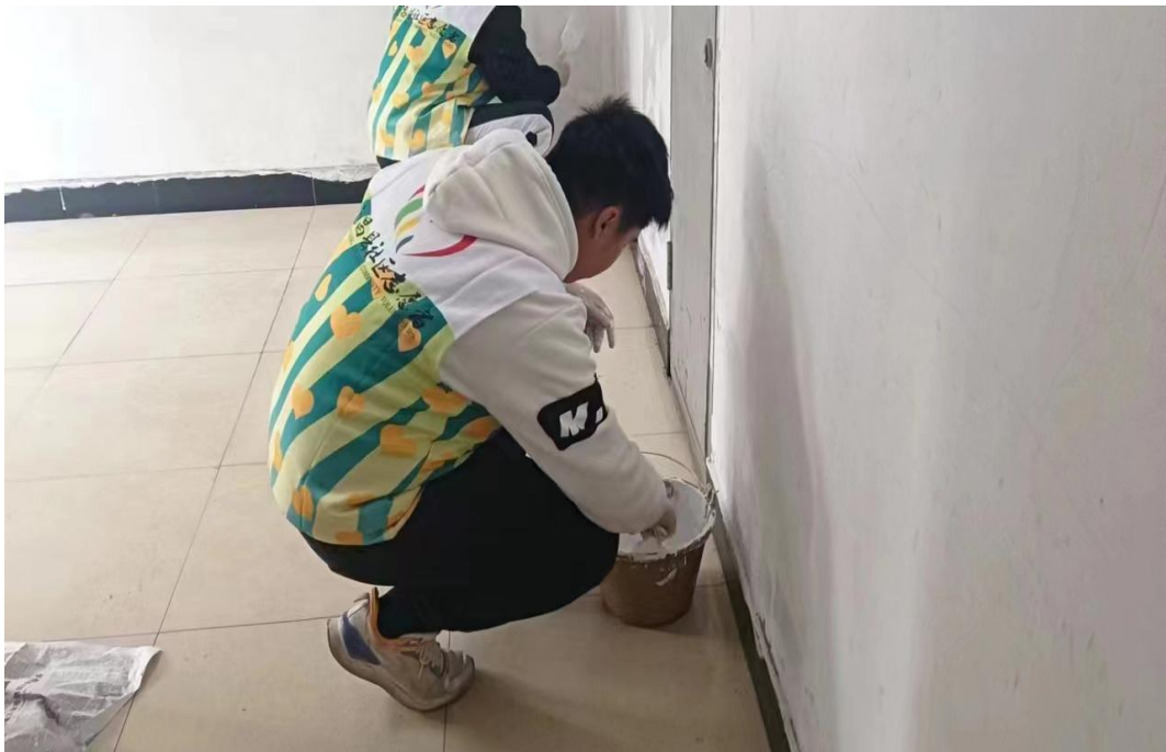
图2-9 星火志愿者们为居民粉刷房屋
